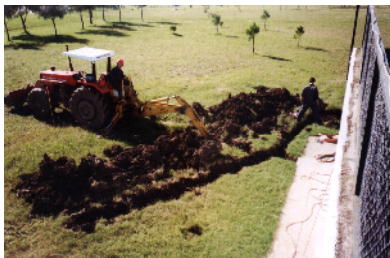
Puesta a tierra tipo "pata de ganso" en Parque de Vacaciones de OSE
