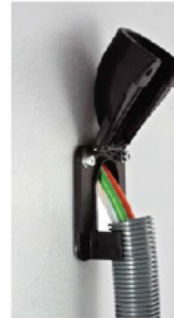
2. Insert conduit with cables
